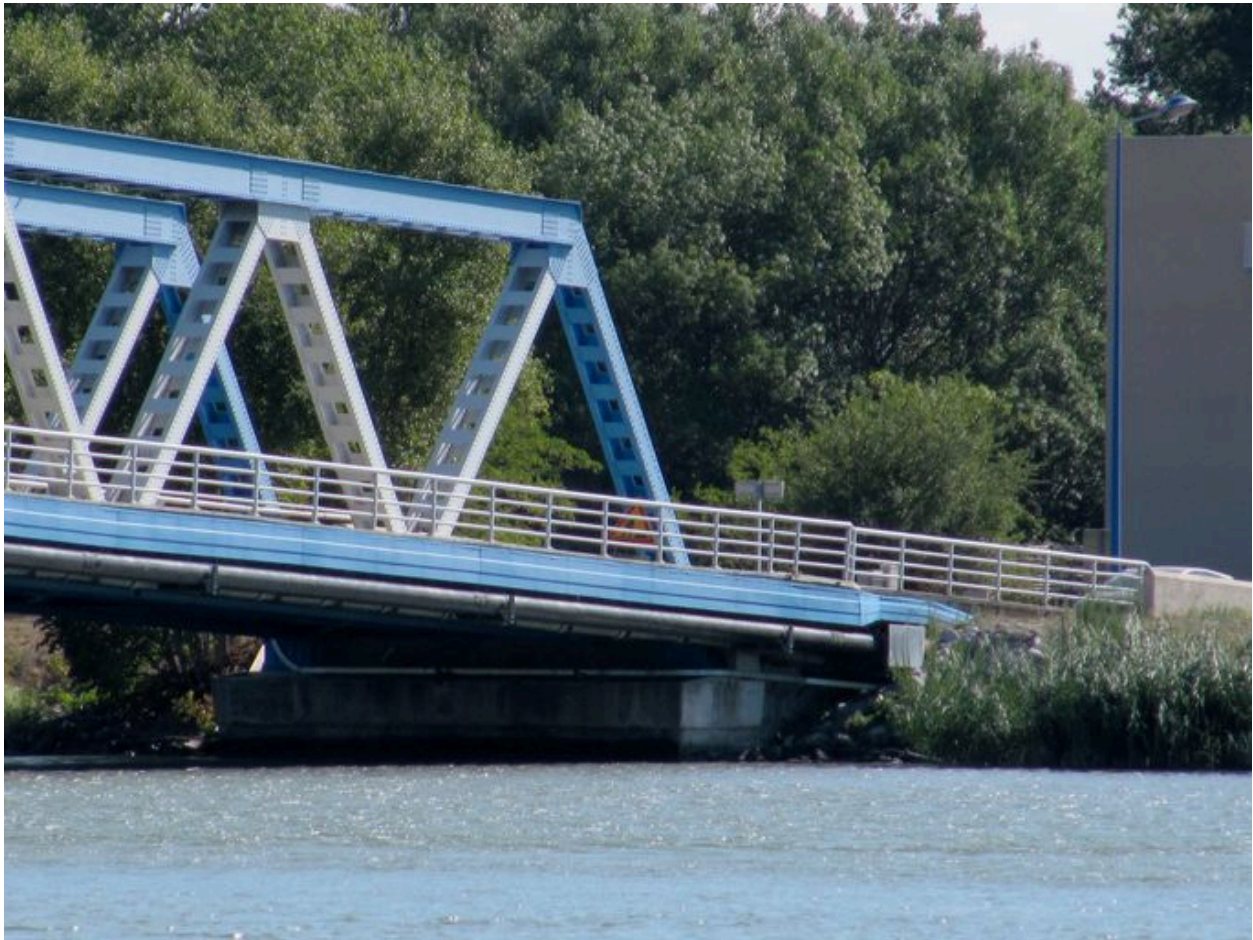
Culée gauche, face aval, vue générale (depuis la rive droite)
