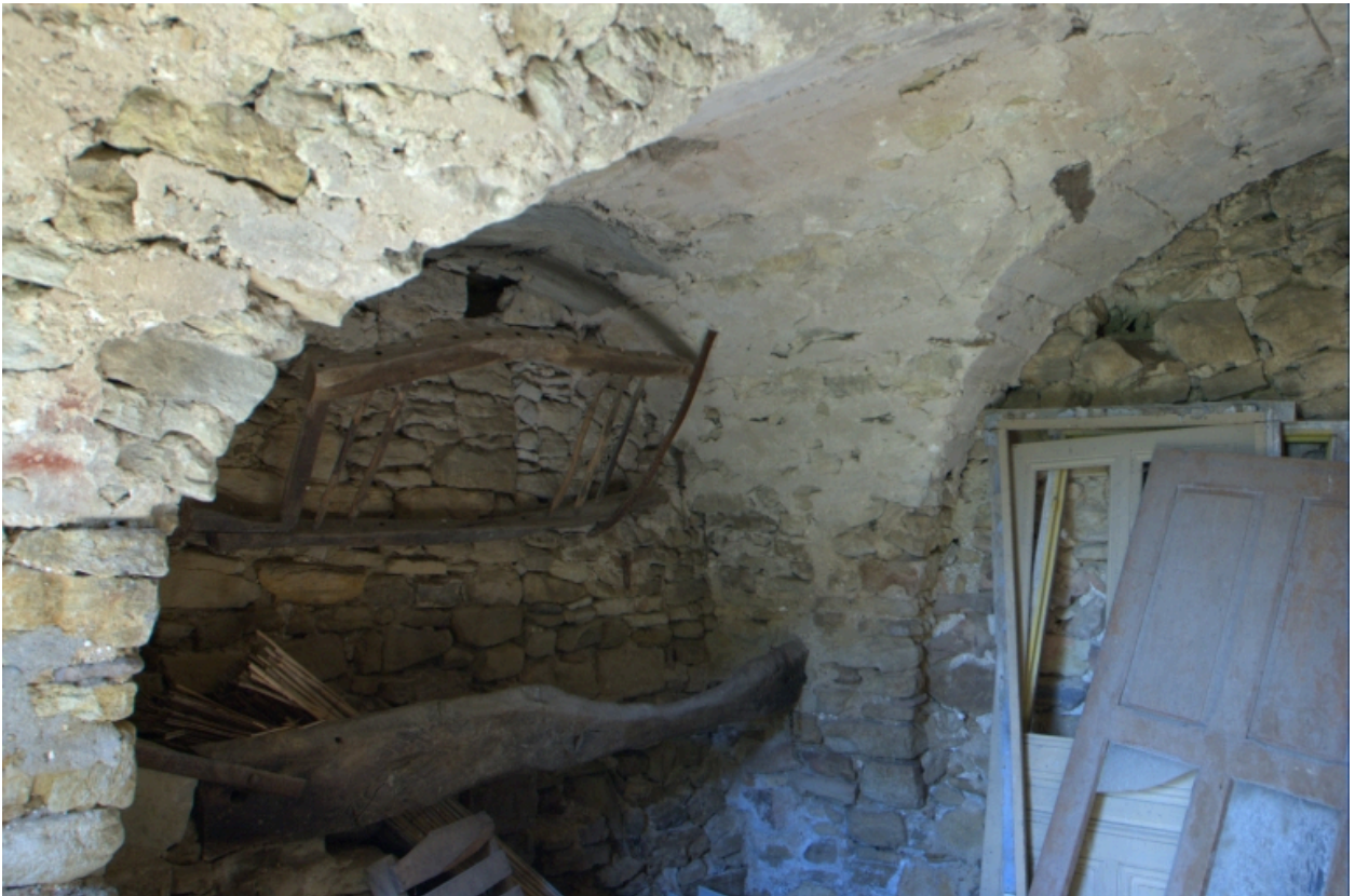
Vue partielle de l'écurie voûtée d'arêtes
