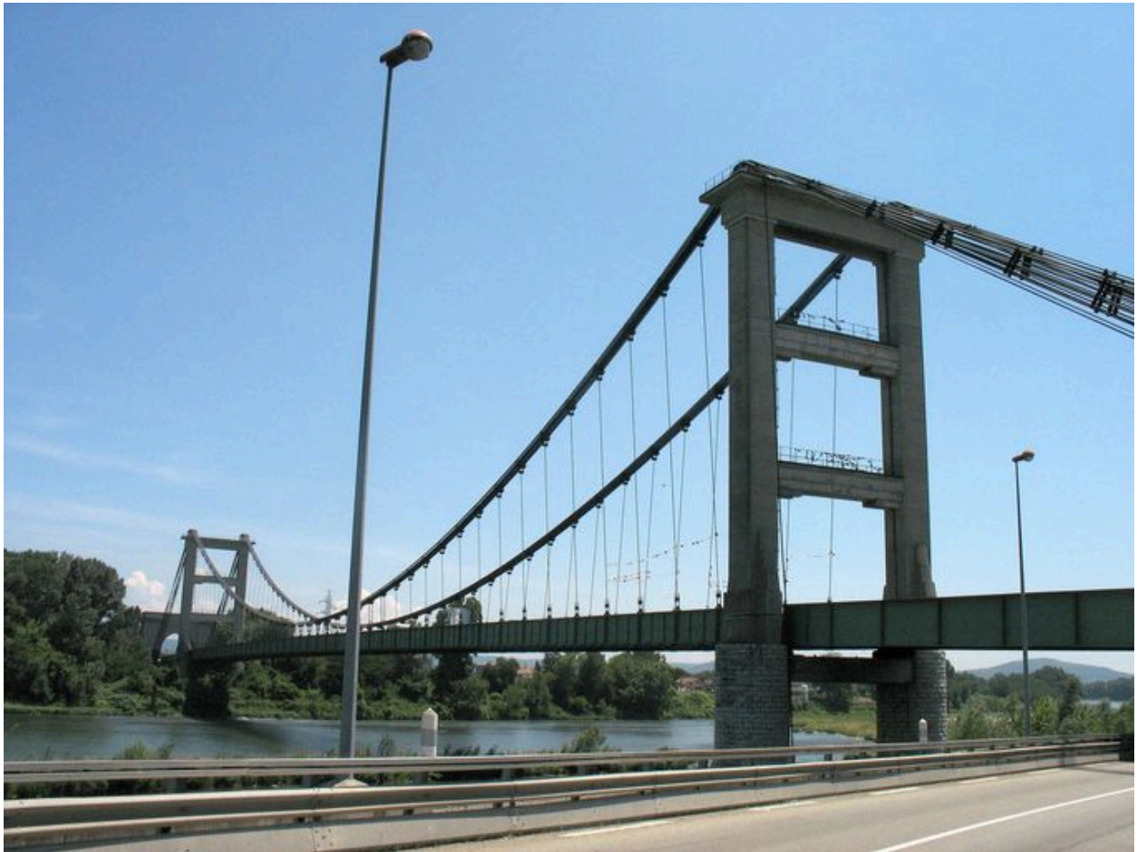
Vue générale, côté amont (depuis la rive droite)
