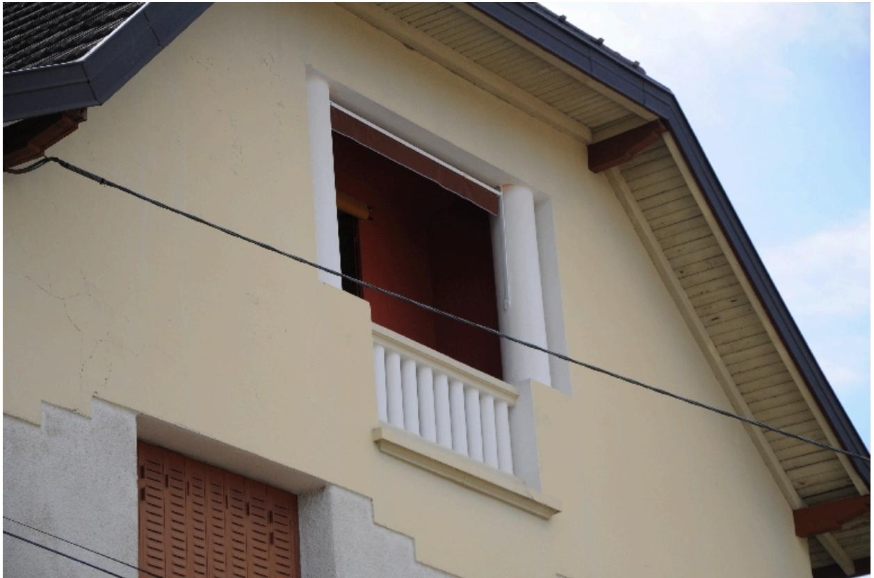
Détail sur la loggia du comble à surcroît
