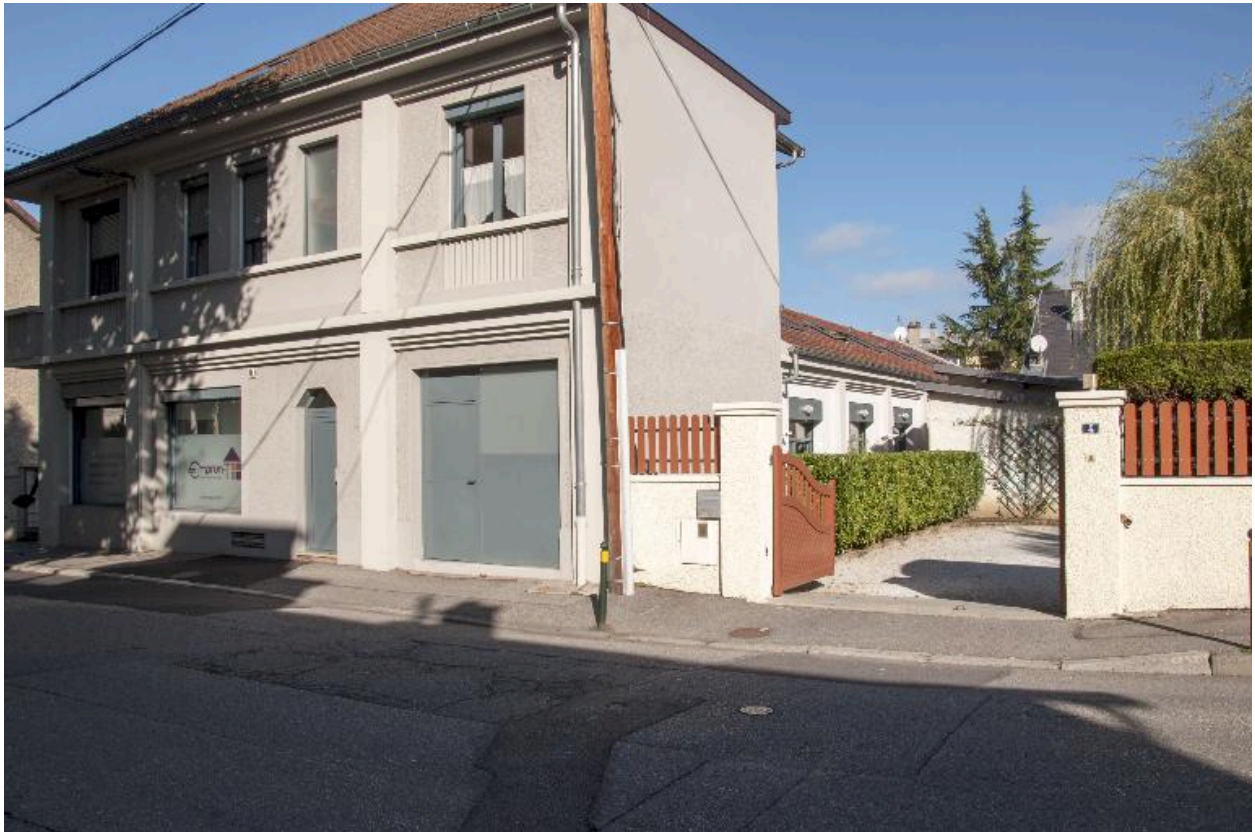
Façade sur rue et élévation postérieure
