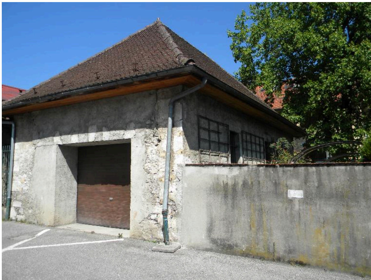
Vue d'un pignon modifié d'un ancien bâtiment rue Asghil Favre (2008 D7 3171).
