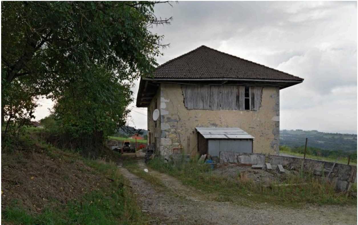
Vue d'ensemble du mur pignon ouest de la ferme.
