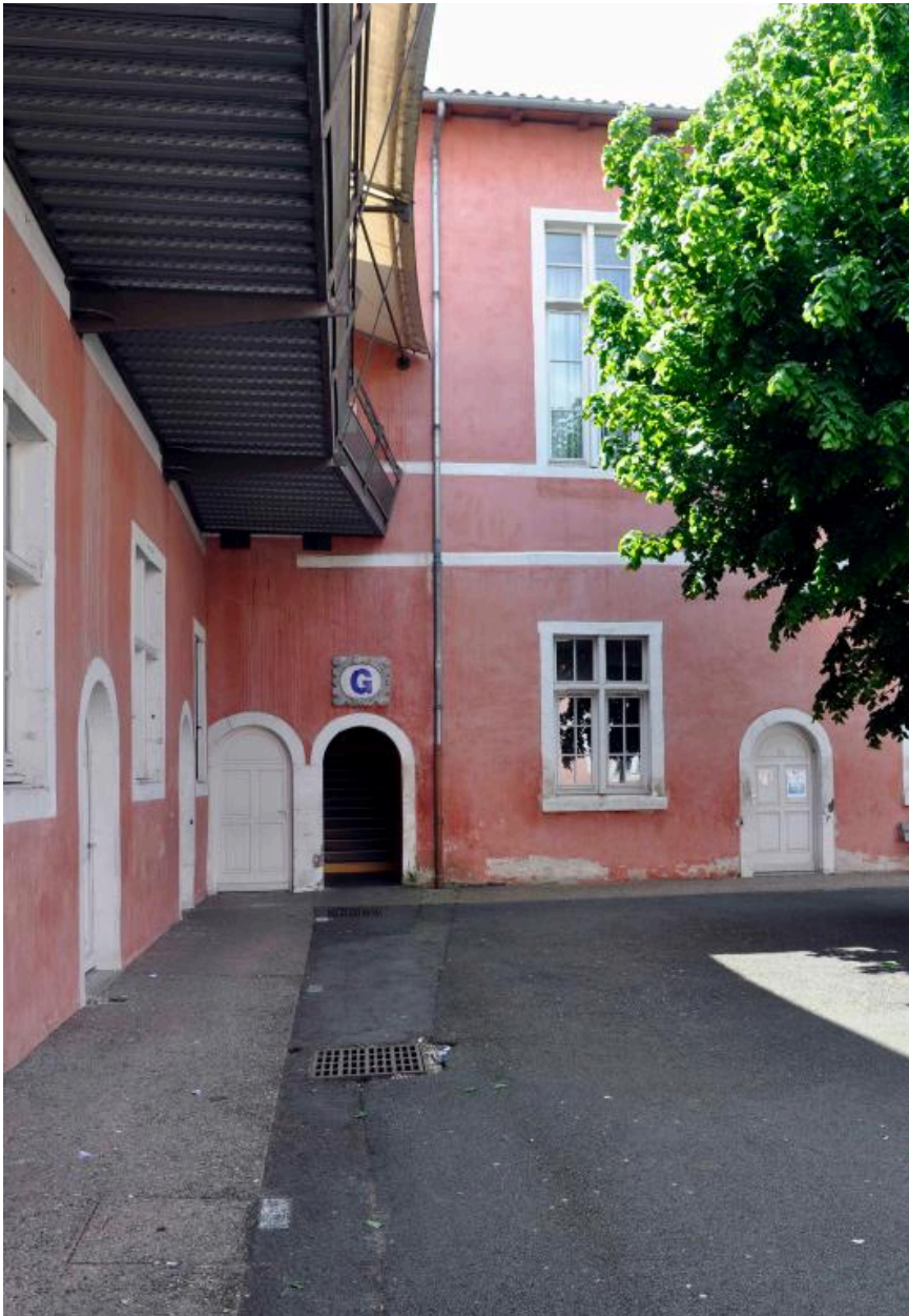
Bâtiment A : élévation sur cour 3, partie sud-ouest
