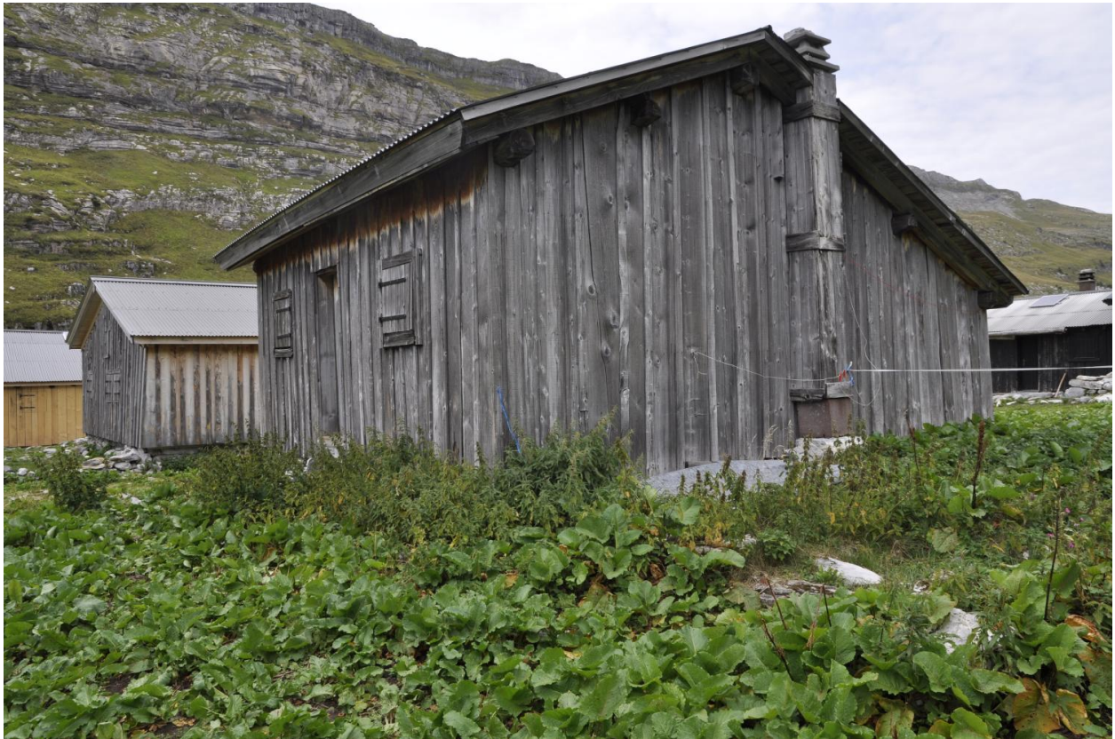
Vue de l'élévation sud-est
