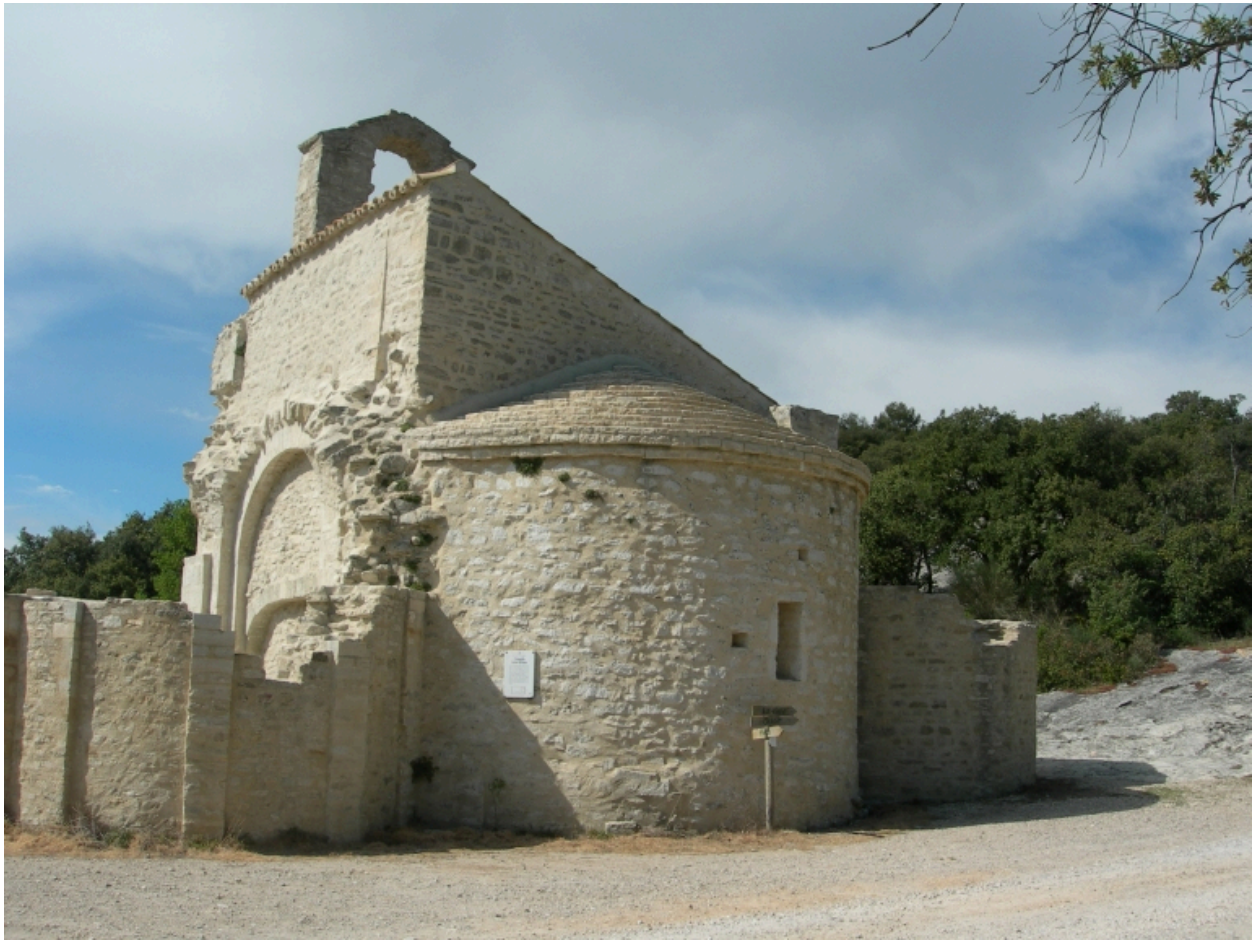
Chapelle restaurée, vue d'ensemble du chevet, prise du sud-est.
