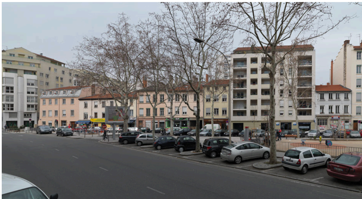
Alignement des façades de la Grande rue de la Guillotière et de la rue Abbé-Boisard (ouest)
