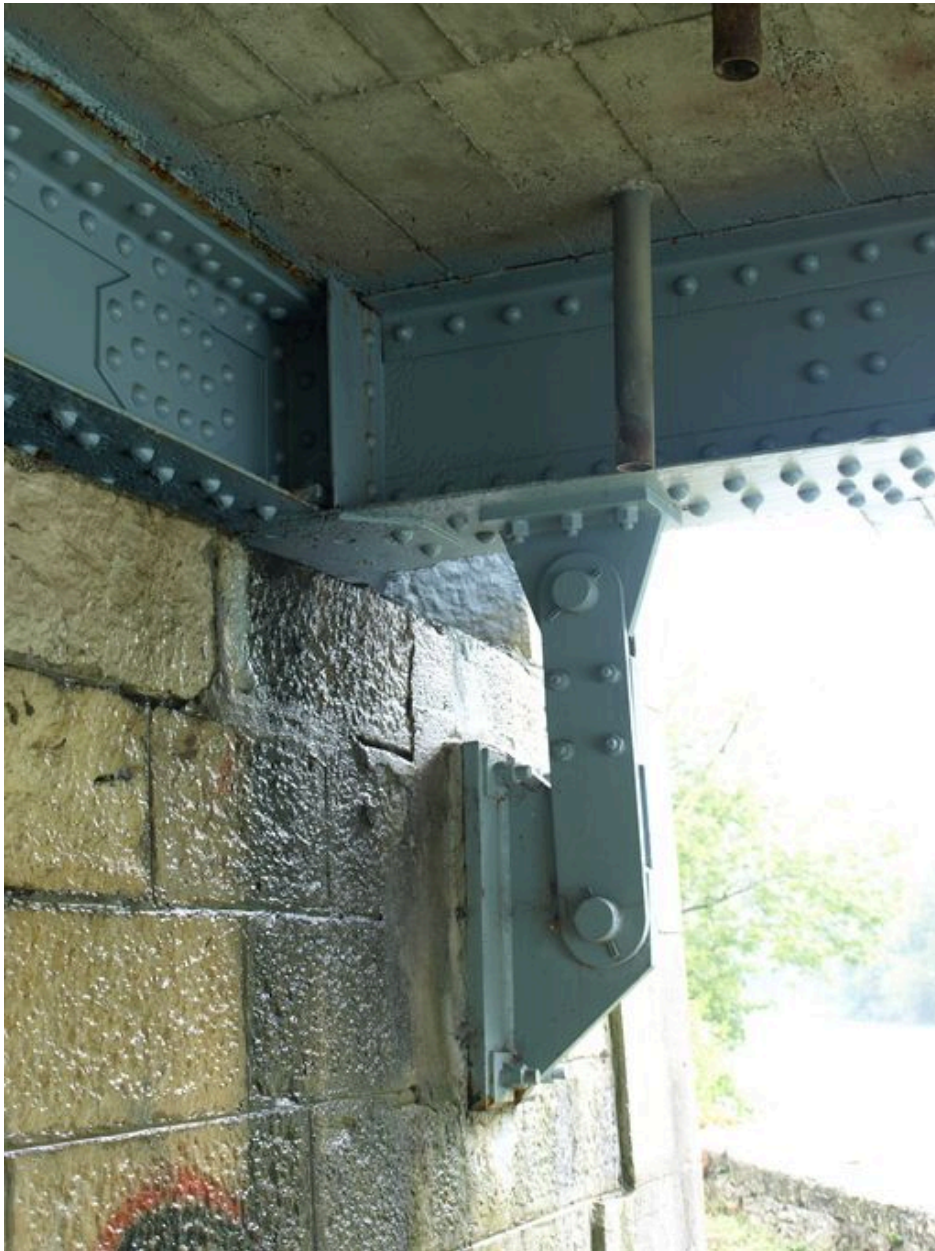
Culée gauche, vue de détail : ancrage du tablier (depuis la rive gauche)
