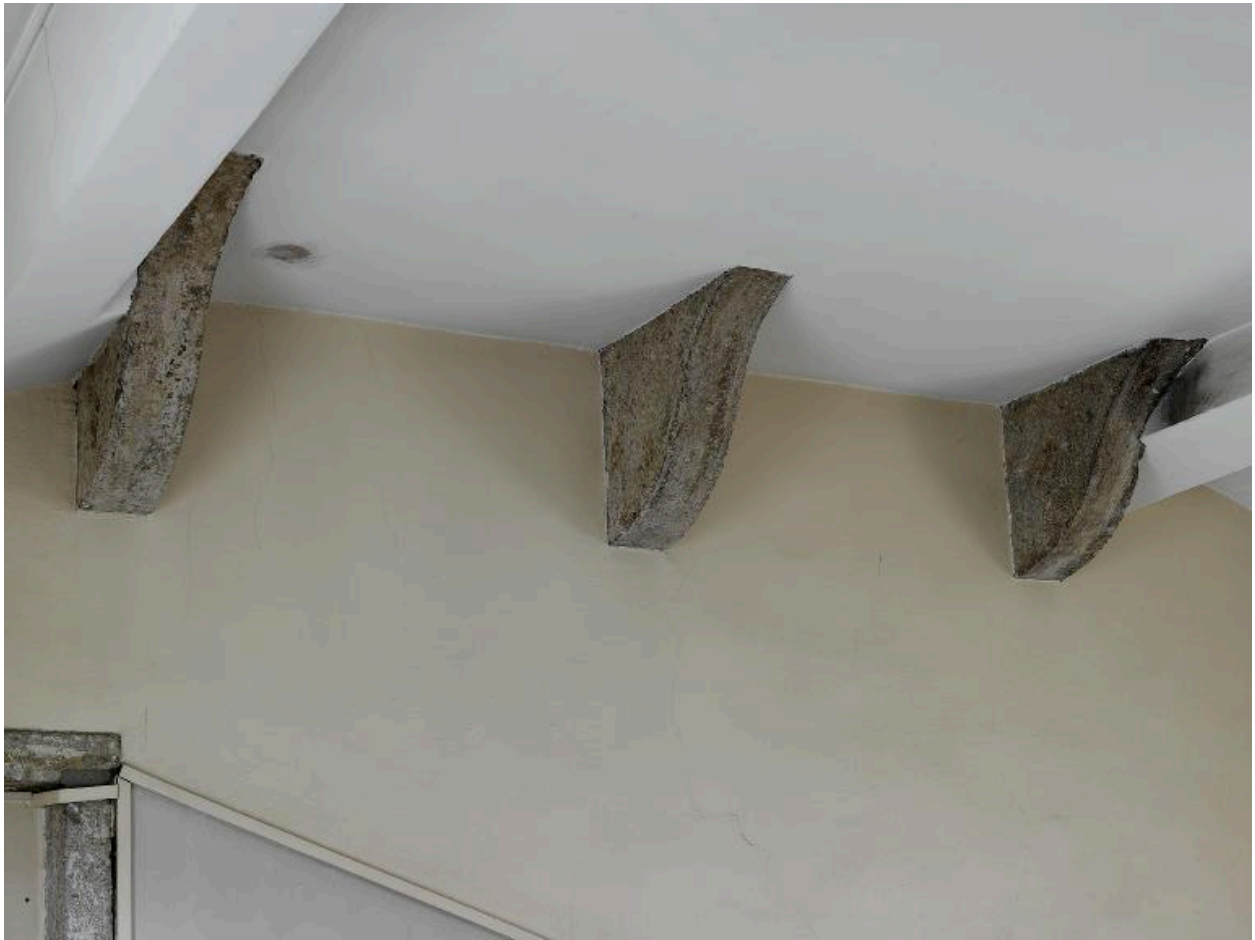
Cage de l'escalier principal, dernier niveau : consoles
