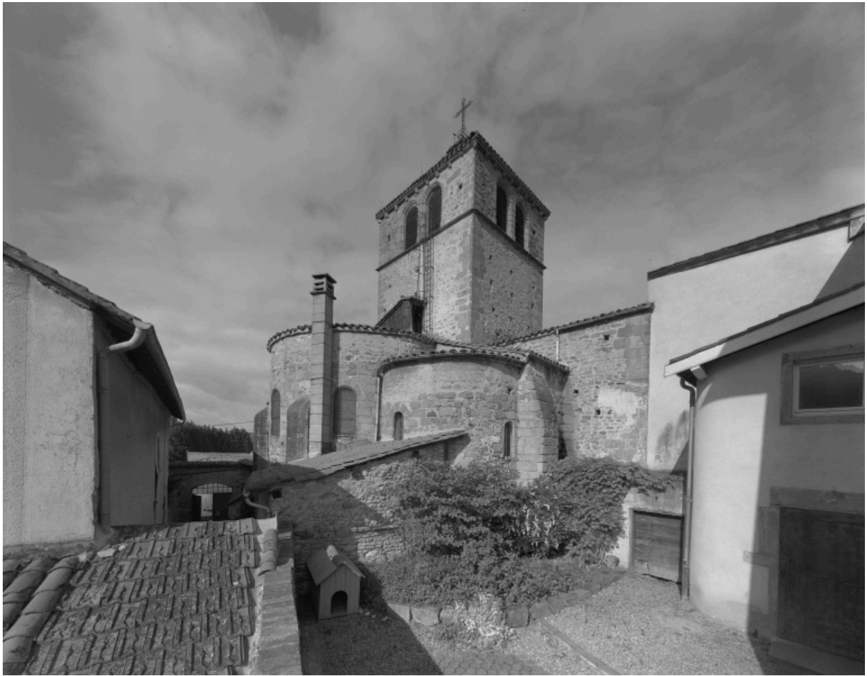
Vue d'ensemble du chevet, clocher et transept, depuis le sud-est.
