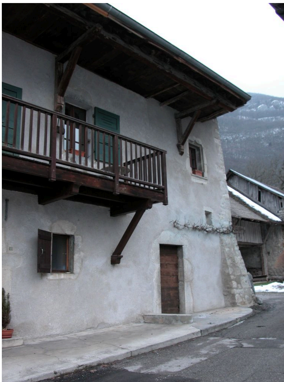
Façade de la ferme à superposition avec renfort à l'angle.
