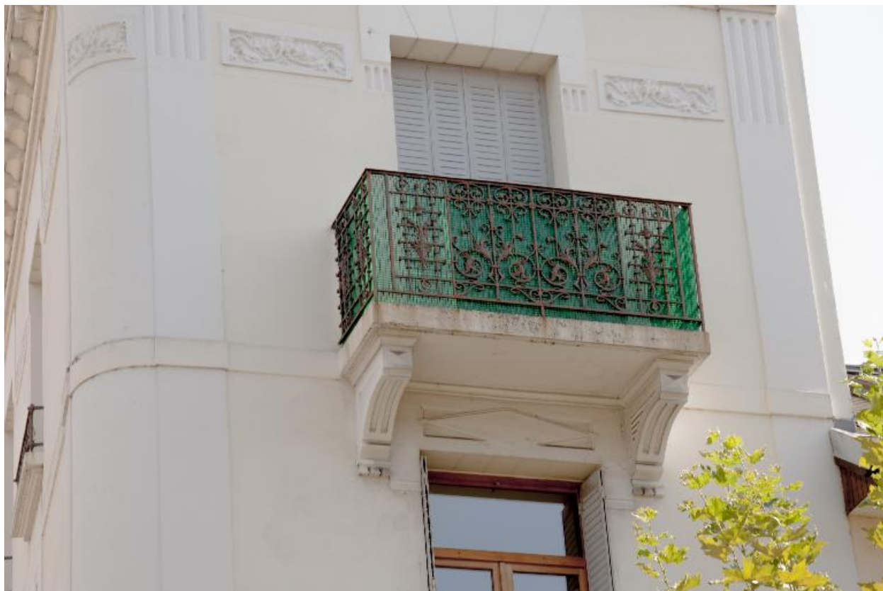
Détail sur les ornements de la façade et le balcon du 3e étage
