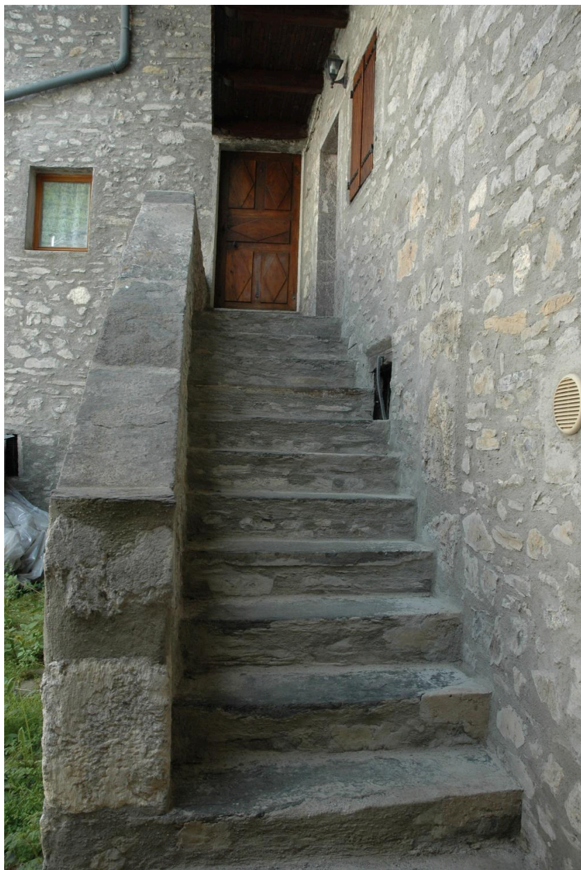
Maisons de vigneron (2018 A5 1037), escalier à garde-corps maçonné.
