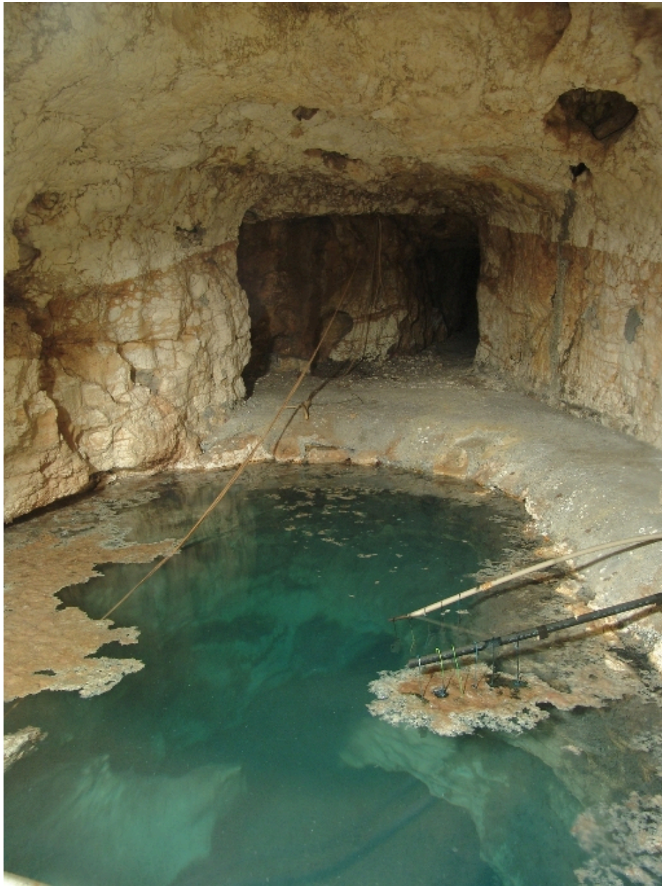
Captage de la source
