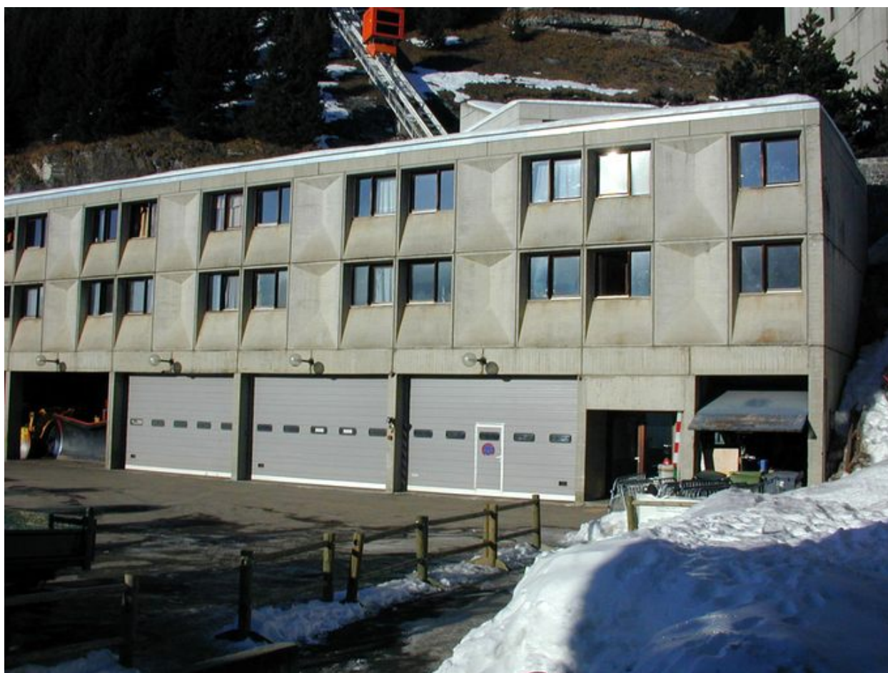
Façade sud. Les garages
