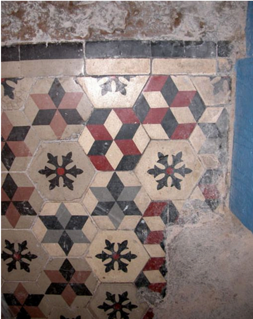
Carrelage en ciment moulé du vestibule
