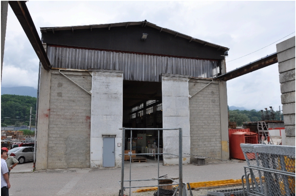
Façade est de l'atelier de mécanique
