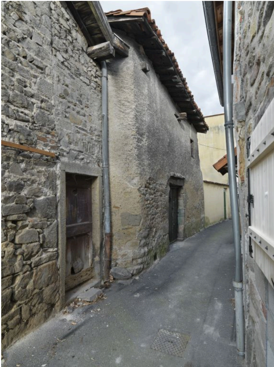
1986 AE 529, rue de la Vieille Cité. Cuvage, vue d'ensemble.
