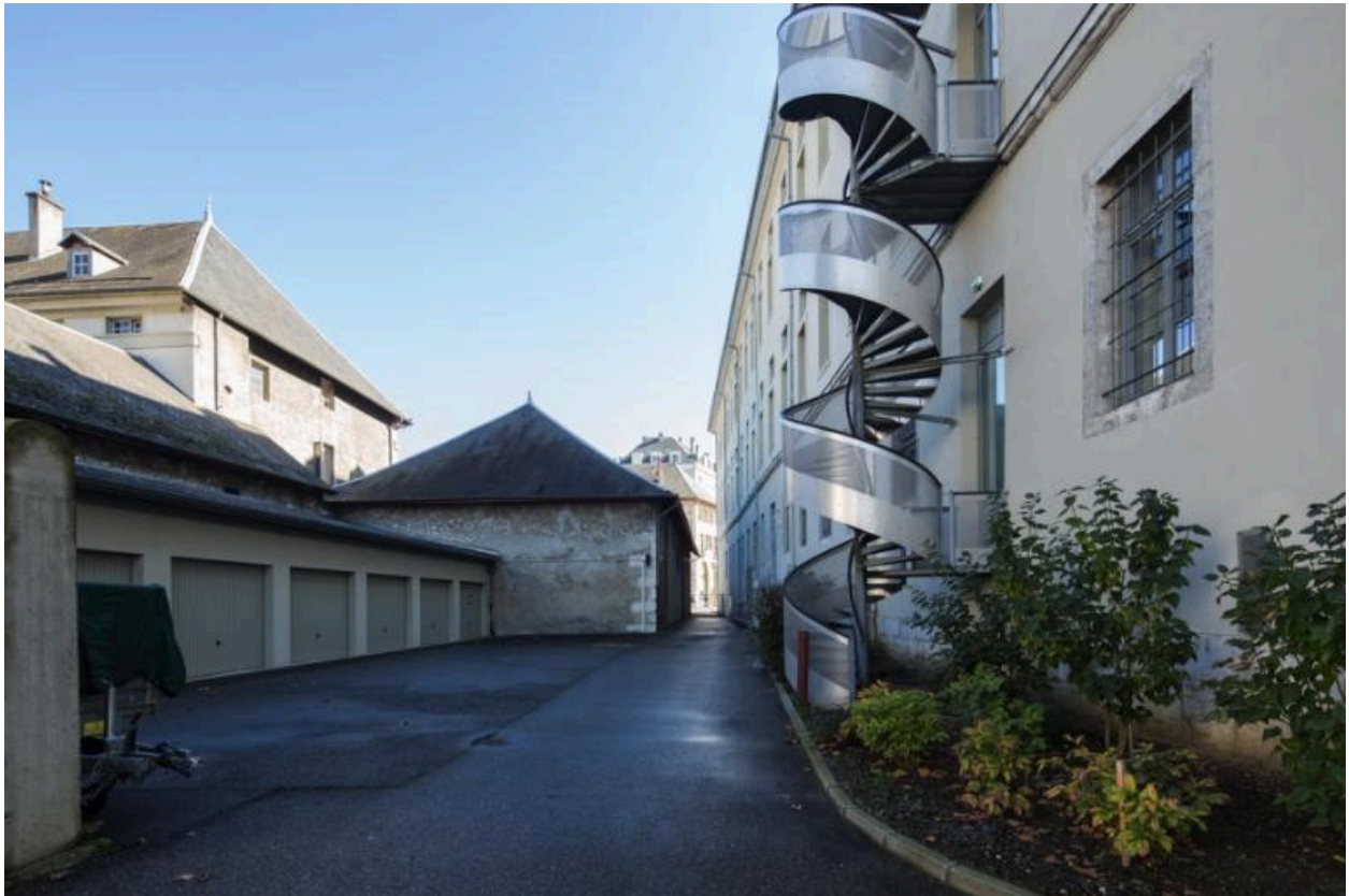
Aile A. Arrière du bâtiment avec escalier de secours.
