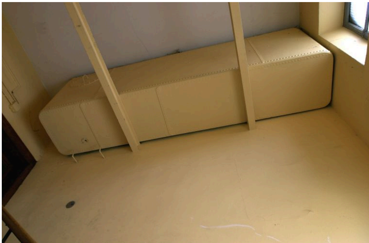
Vue de la citerne en tôle au dernier étage
