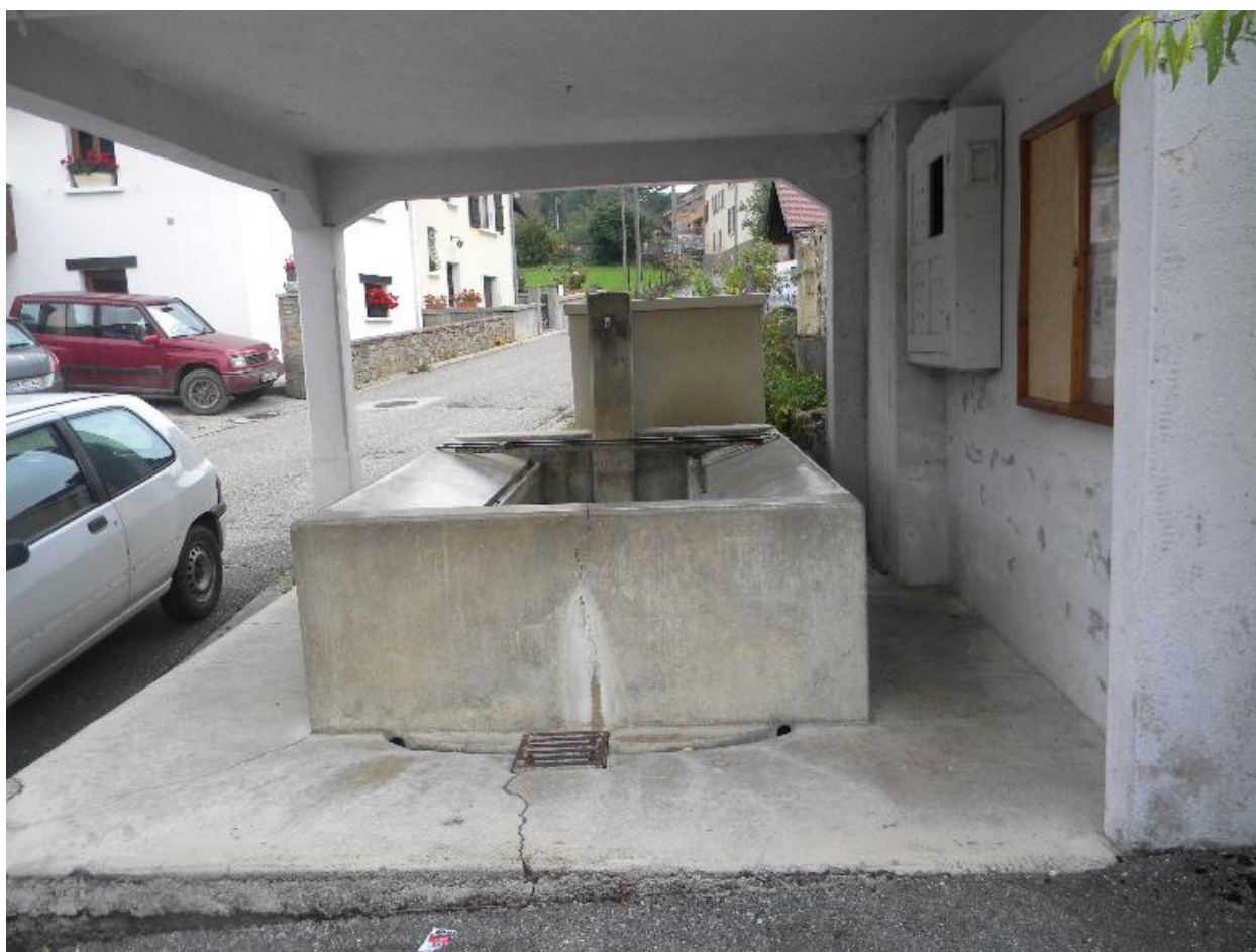
Vue du lavoir sous son toit.
