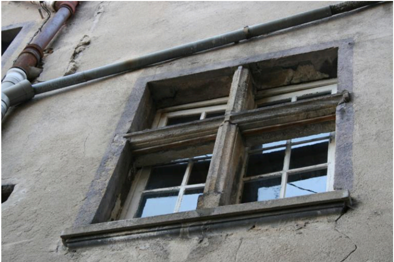
Fenêtre à meneaux de l'élévation sur la rue des Sapeurs-Pompiers, côté sud (photographie chercheur).
