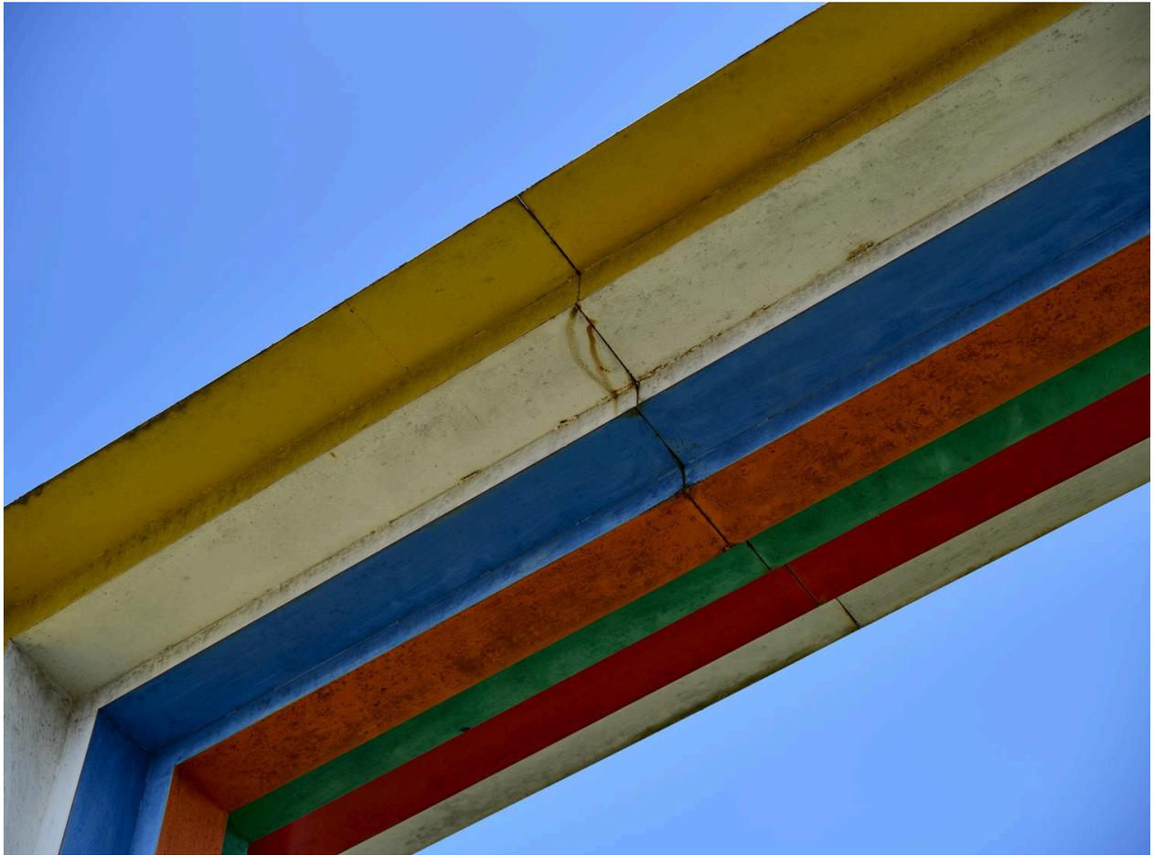
Détail des altérations : corrosion, partie supérieure
