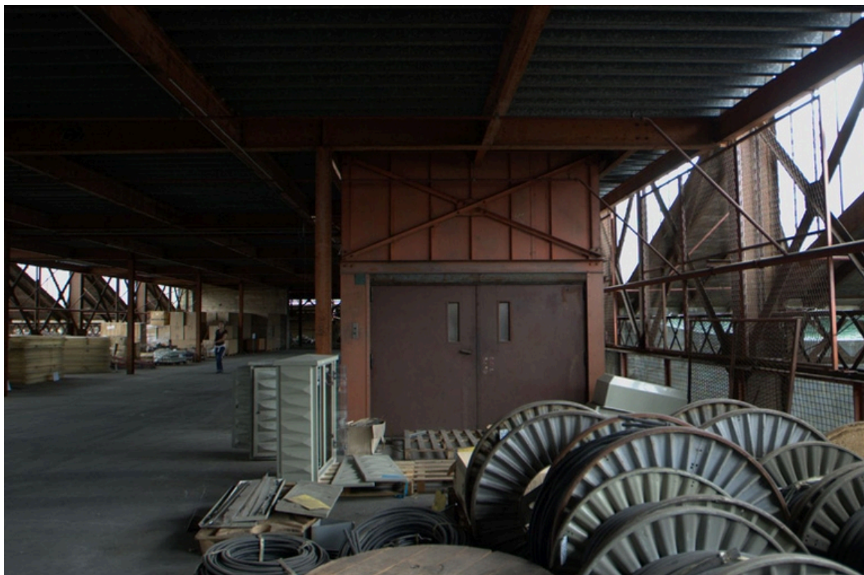
Monte-charge deuxième niveau
