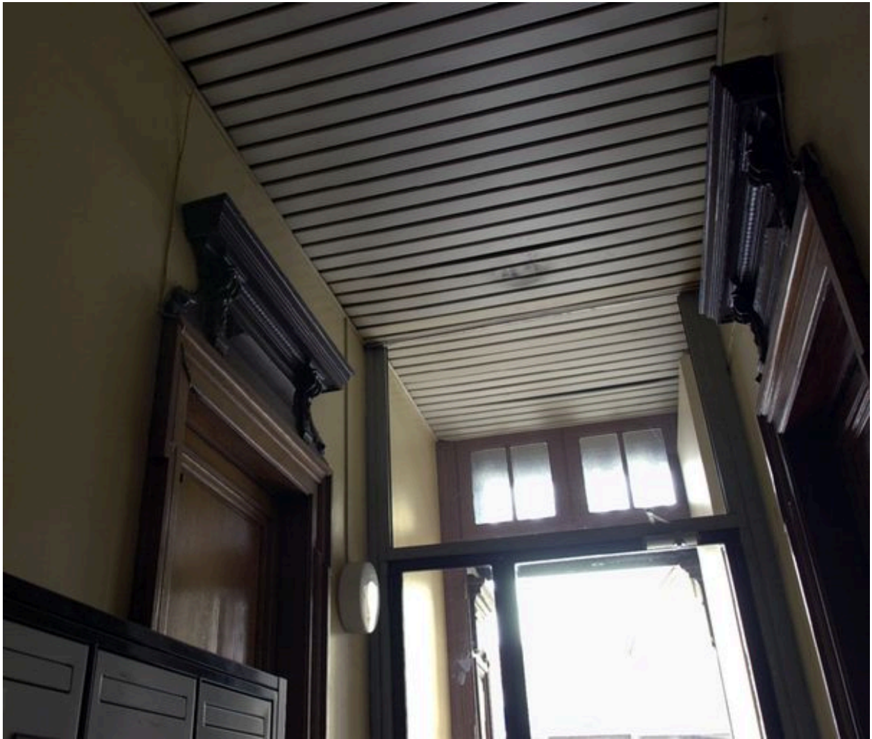
Vestibule, détail des encadrement des portes intérieures
