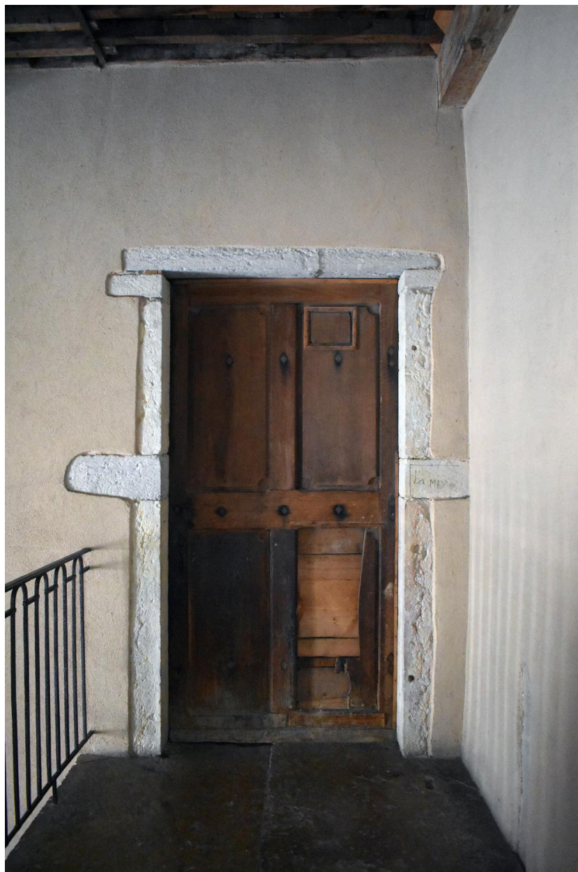
Bâtiment C : escalier G, 2e palier, porte sud
