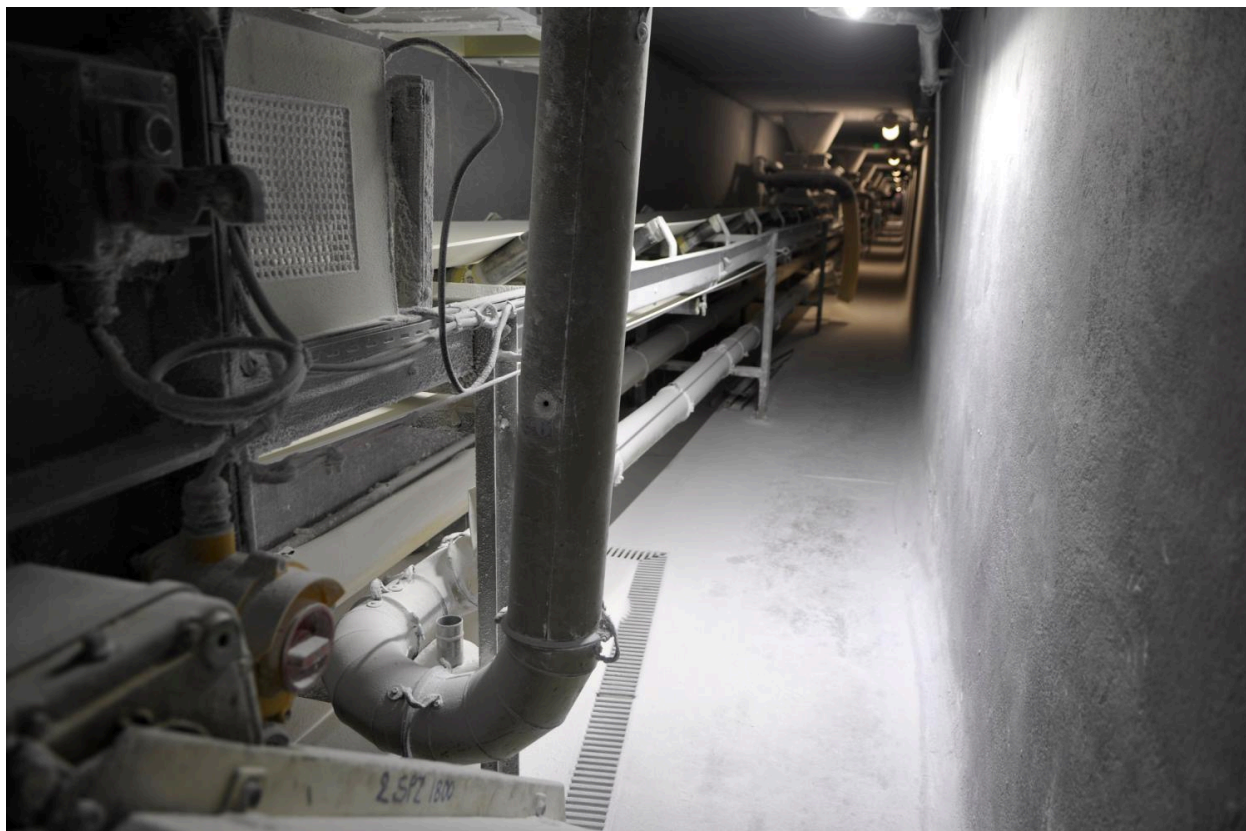
Transporteur de la grande halle de stockage des sucres
