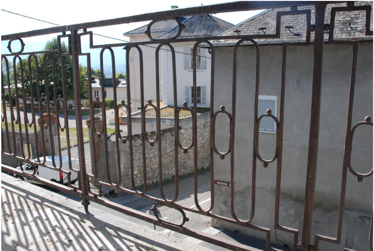
Détail du garde-corps du balcon sud.
