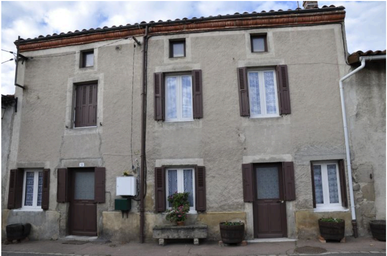
1986 AE 145, 2 rue des Vignerons. Remise, vue d'ensemble.
