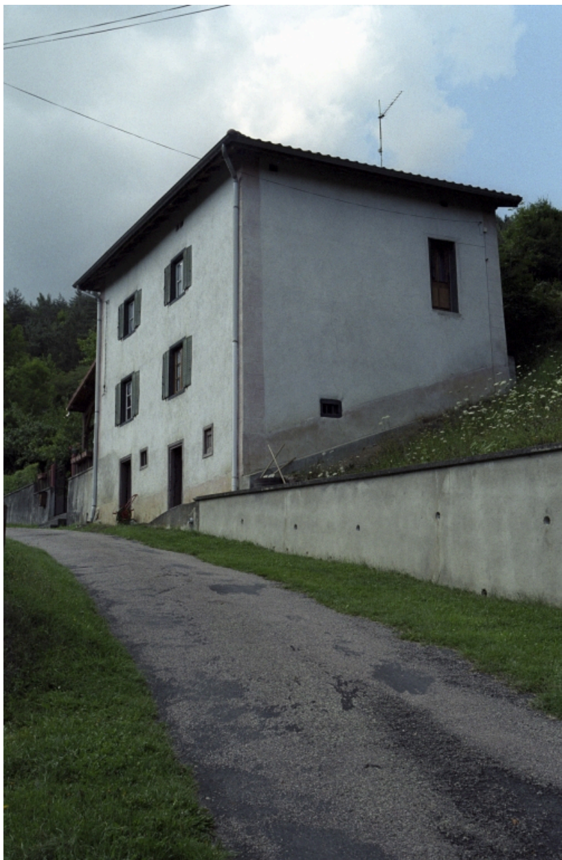
Saint-Laurent-Rochefort, Collet (1987 A3 1588), type A3. Vue d'ensemble depuis la route : élévations latérale et postérieure du logis, étable en rez-de-chaussée.
