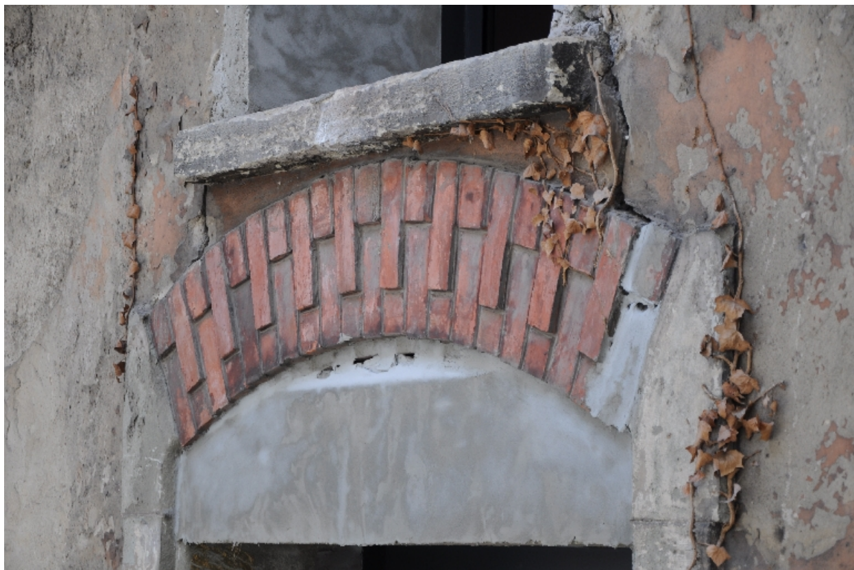
Détail de l'arc segmentaire du dessus-de-porte
