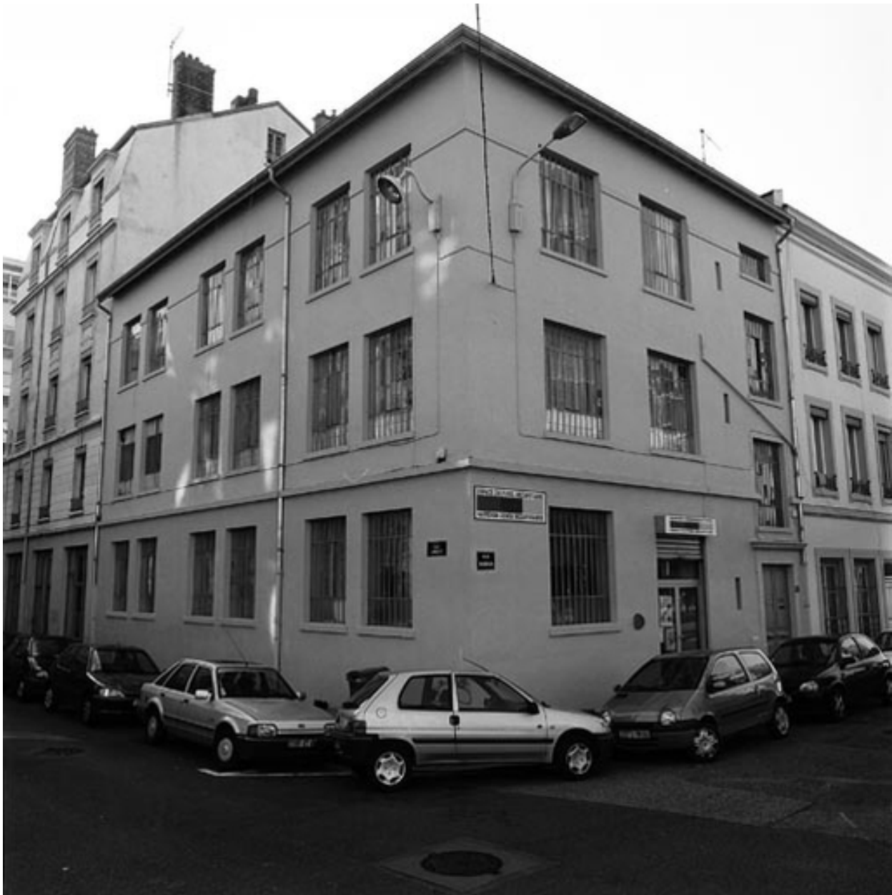
Vue générale ouest
