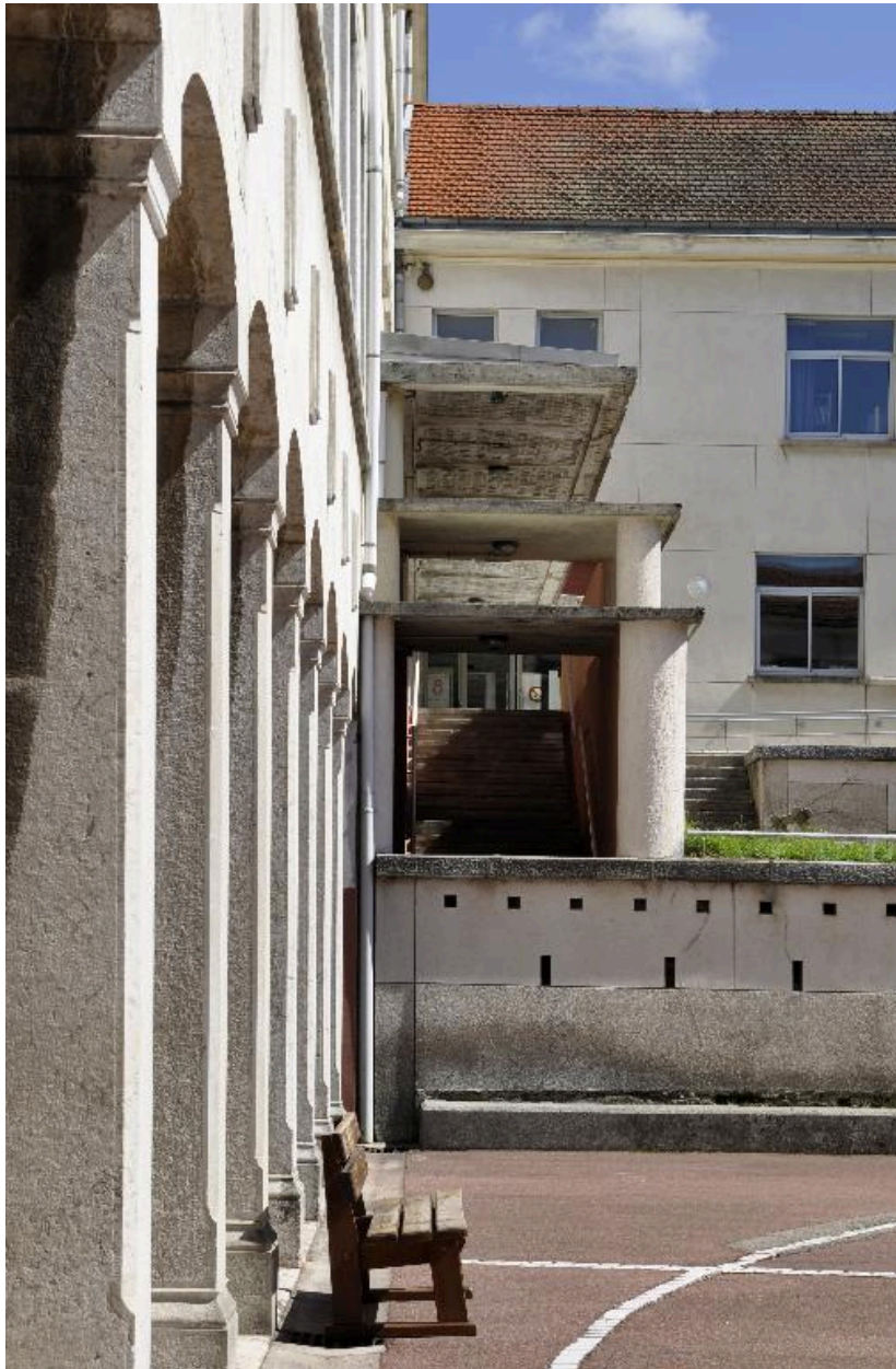
Montée d'escalier couverte, détail
