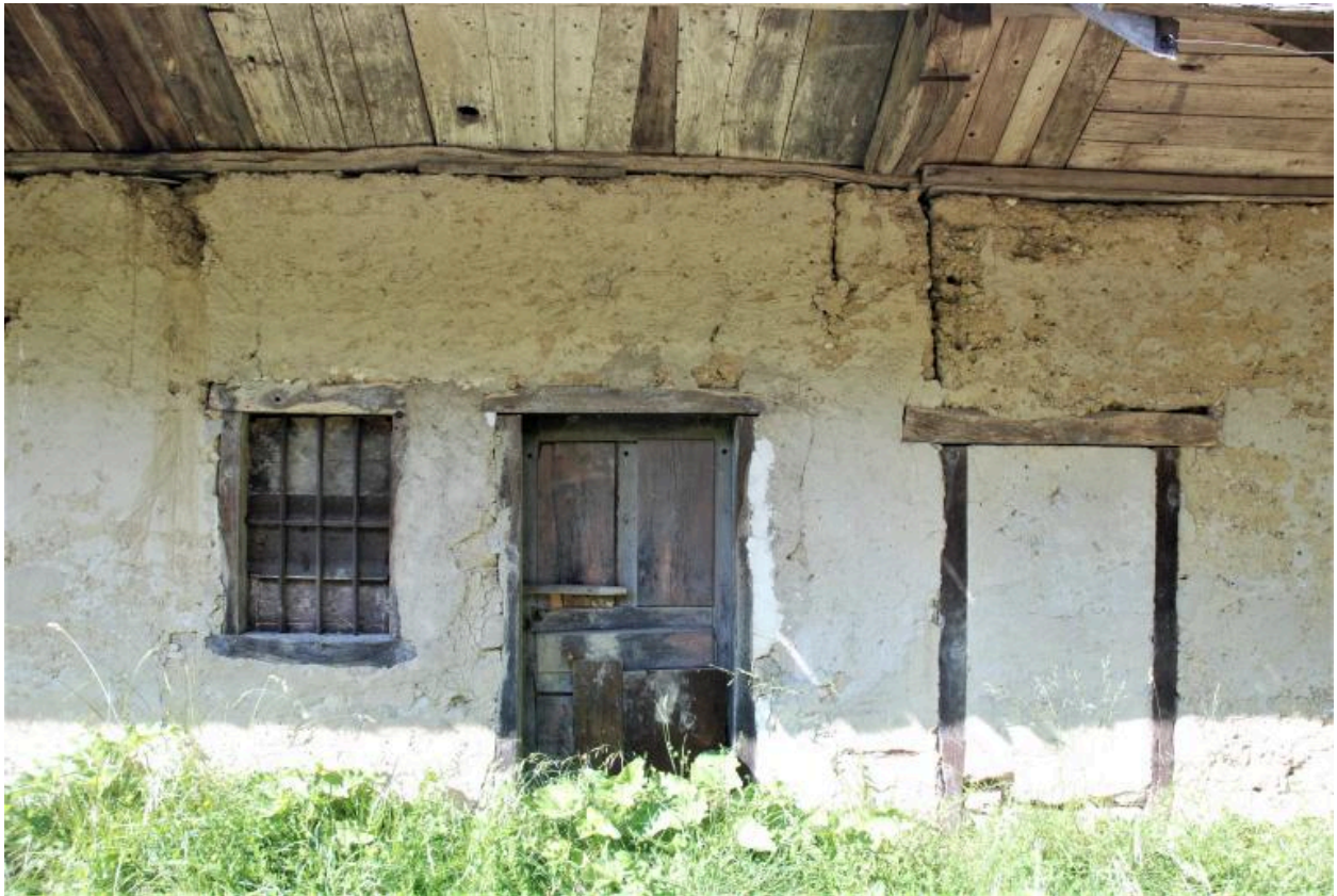
Façade de la partie habitation.
