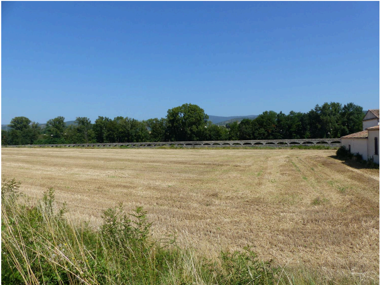
Vue générale de l'aqueduc
