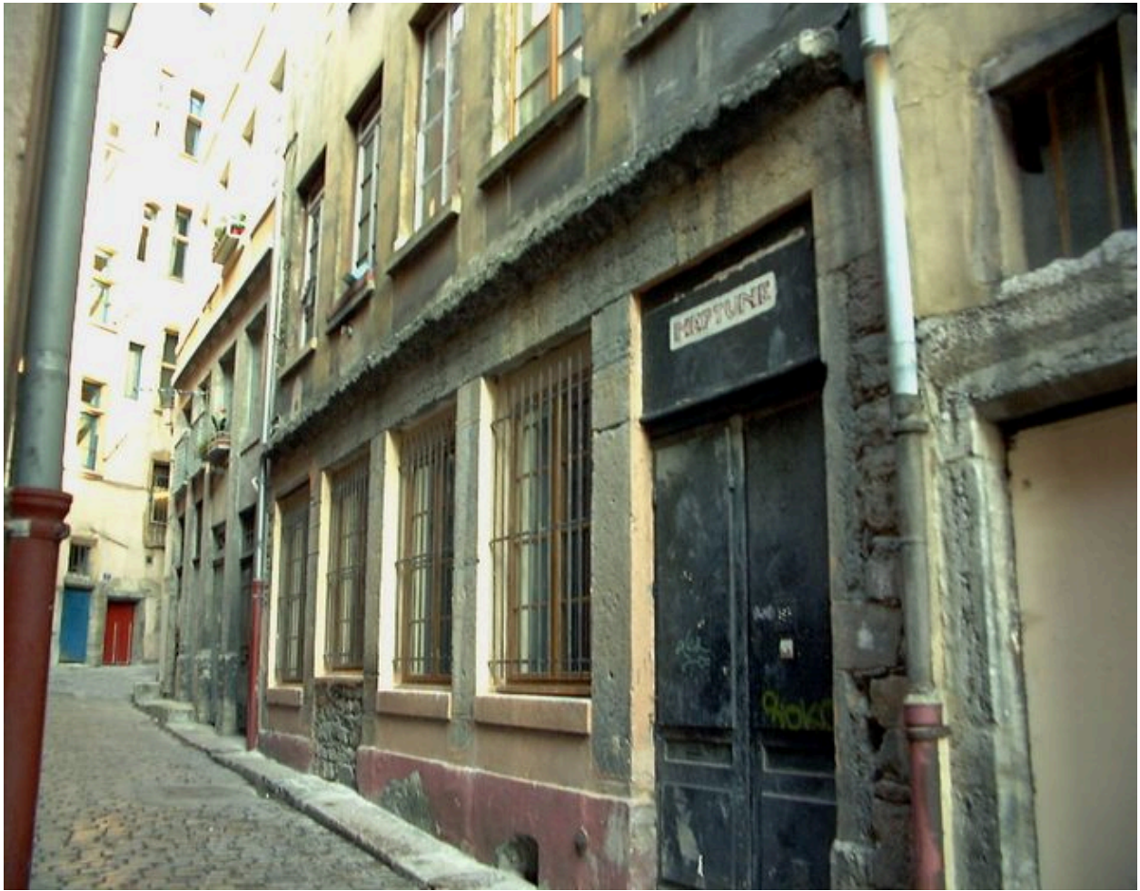
Vue du rez-de-chaussée
