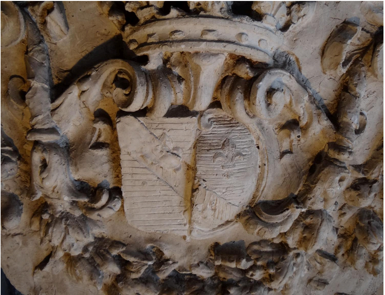
Vue générale de HC 178-17
