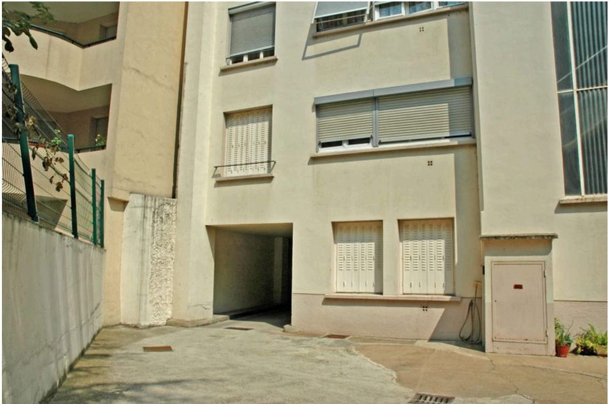
Vue du passage couvert depuis la cour
