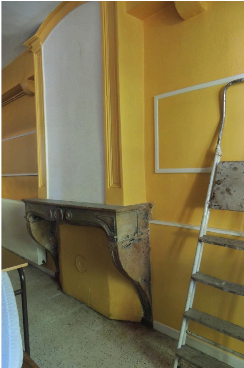
Rez-de-chaussée, ancienne salle de catéchisme : cheminée à trumeau.
