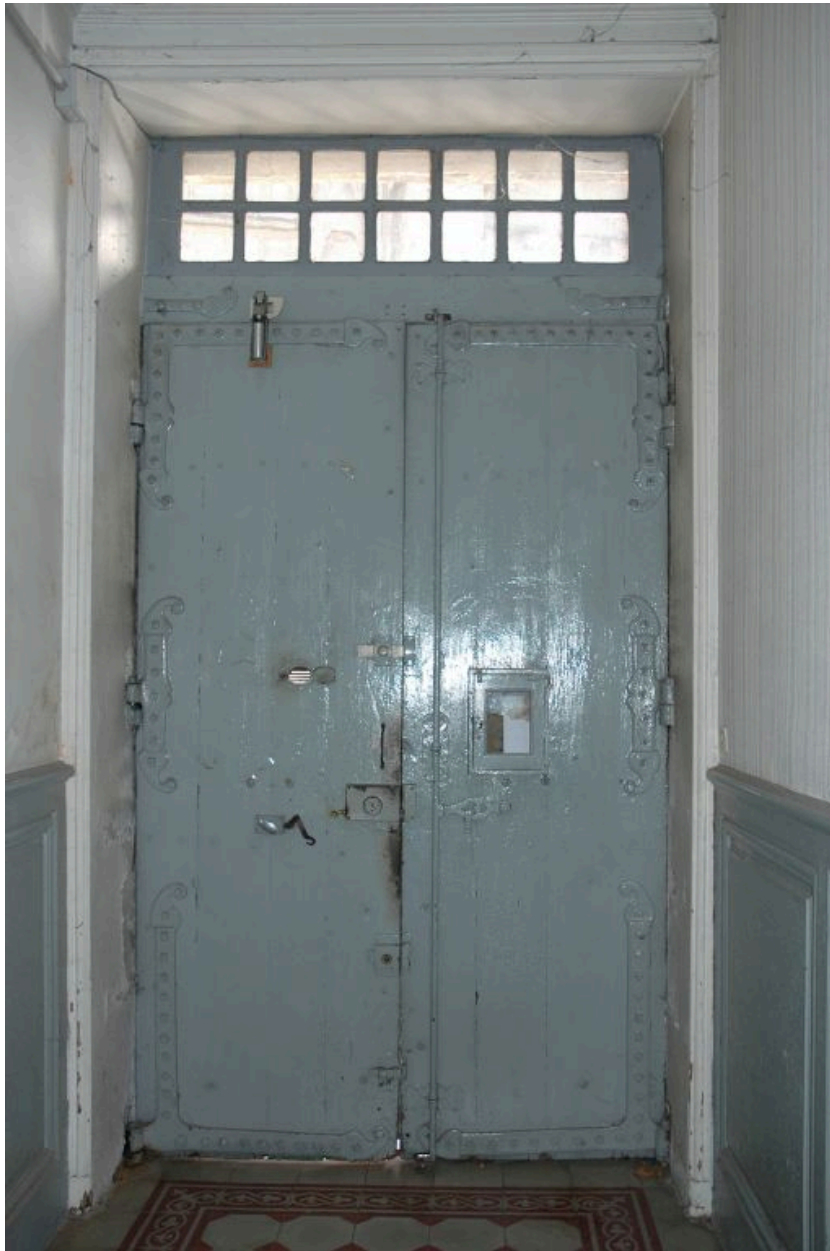
Porte piétonne, vue du revers.
