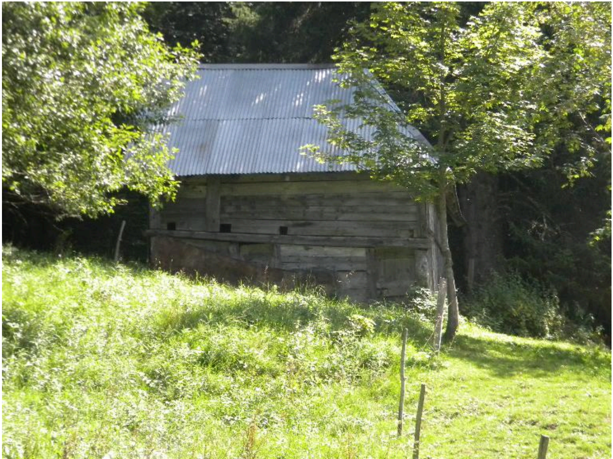
Vue d'une ancienne grange aux Molines
