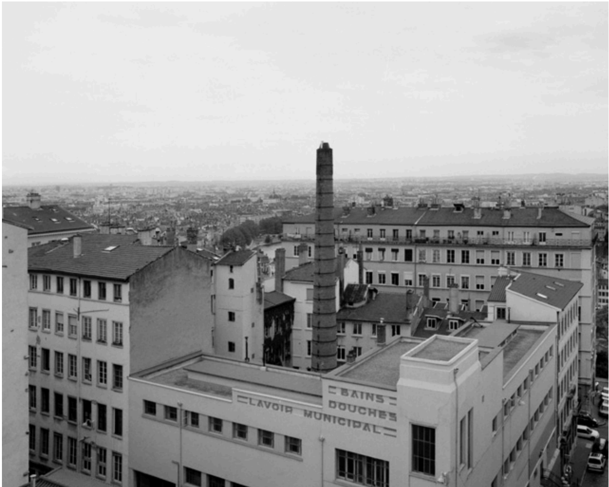
Vue du toit terrasse
