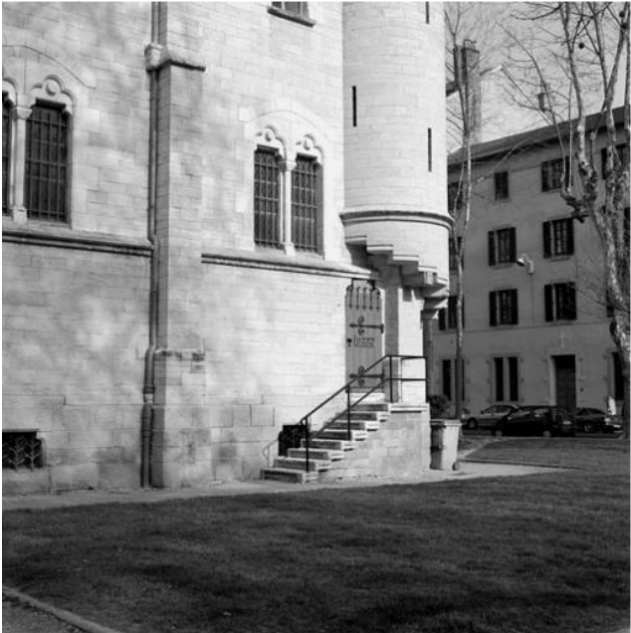
Élévation sud, sacristie : détail de la petite porte surmontée d'une tourelle d'angle
