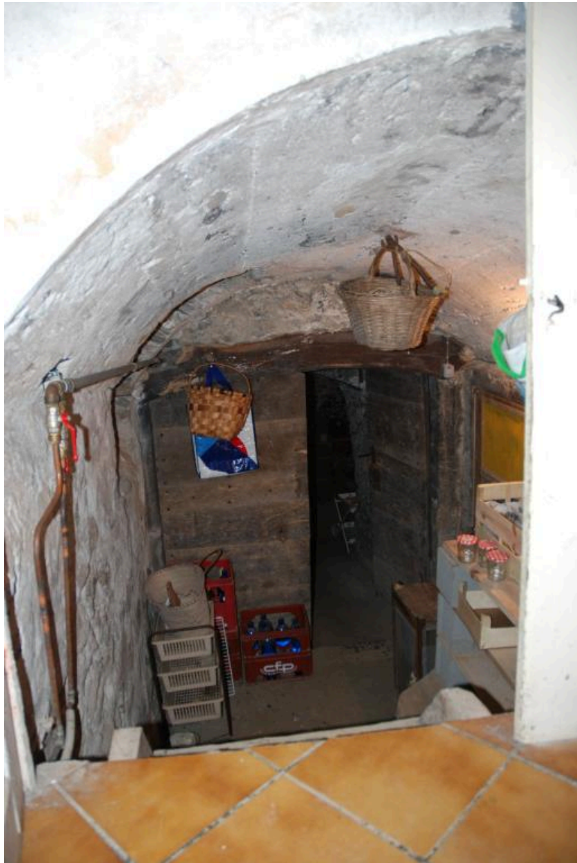
Corps principale, rez-de-chaussée, partie sud, salle à manger (Cf. Plan RDC 8b), vue sur l'accès aux caves voûtées.
