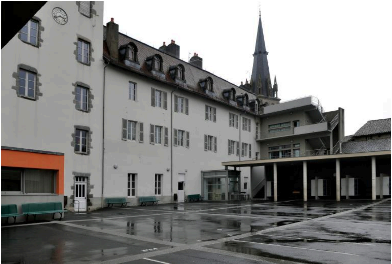
Bâtiment C : élévation sur cour, vue partielle depuis le sud-ouest
