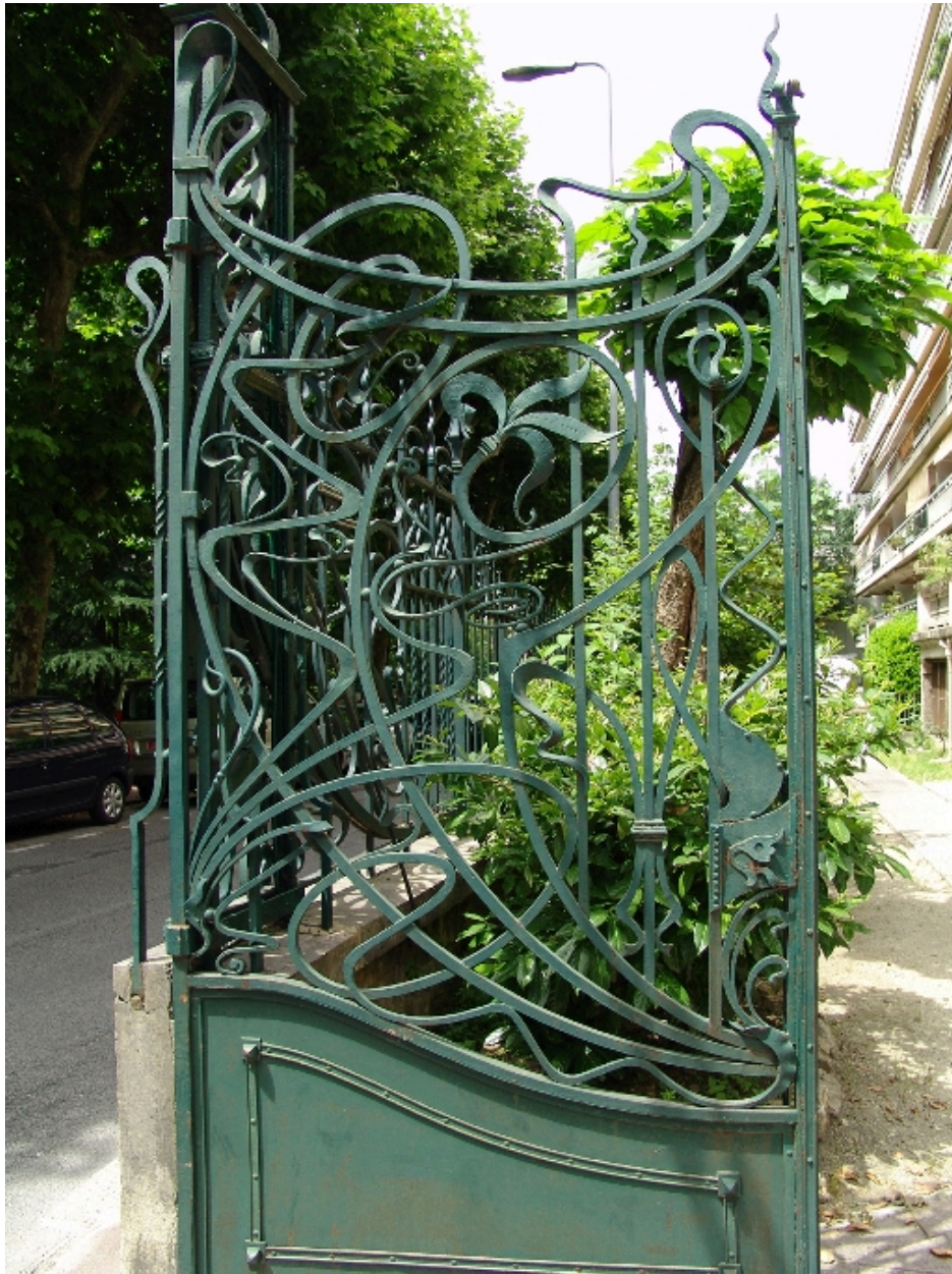
Vantail du portail d'entrée
